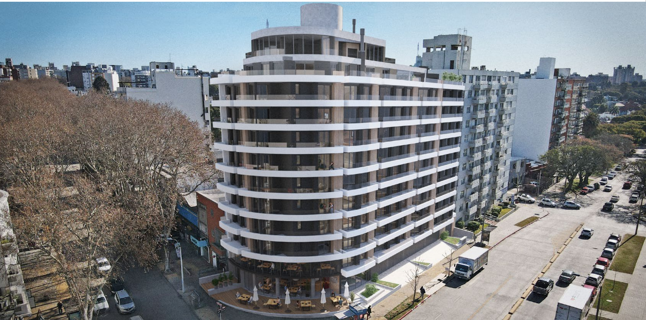
Obra Pont Bleu
